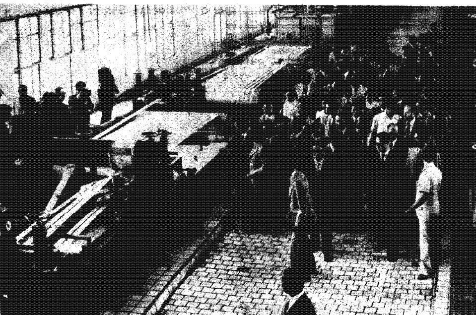
O combinado industrial de «Vinalon». Os tecidos que vemos são fabricados a partir da pedra, quer dizer, a partir da transformação química do amianto.
