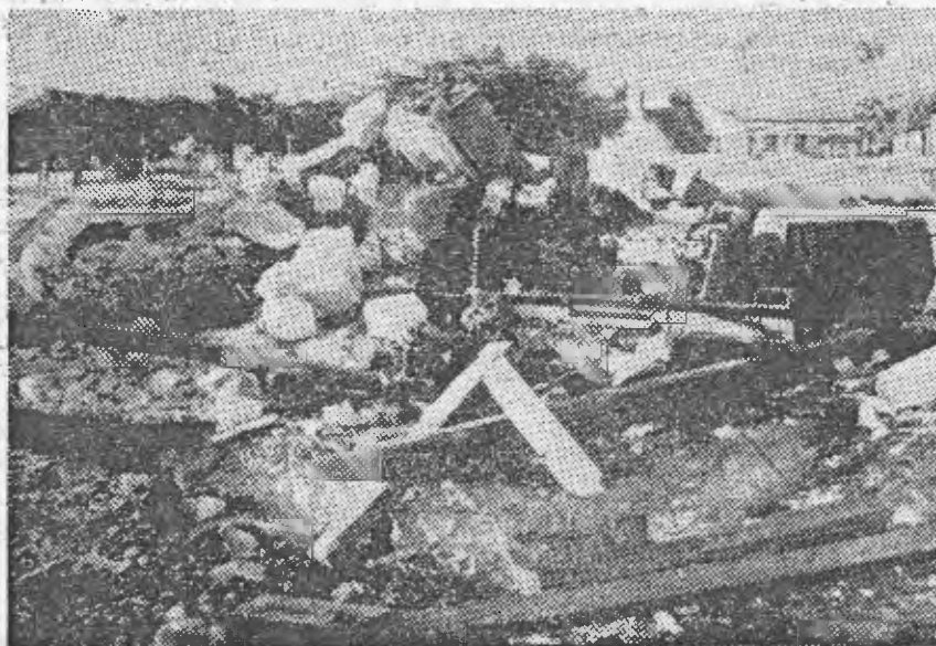
Estado em que ficou o gerador que fornecia energia eléctrica a Vila de Inhaminga
