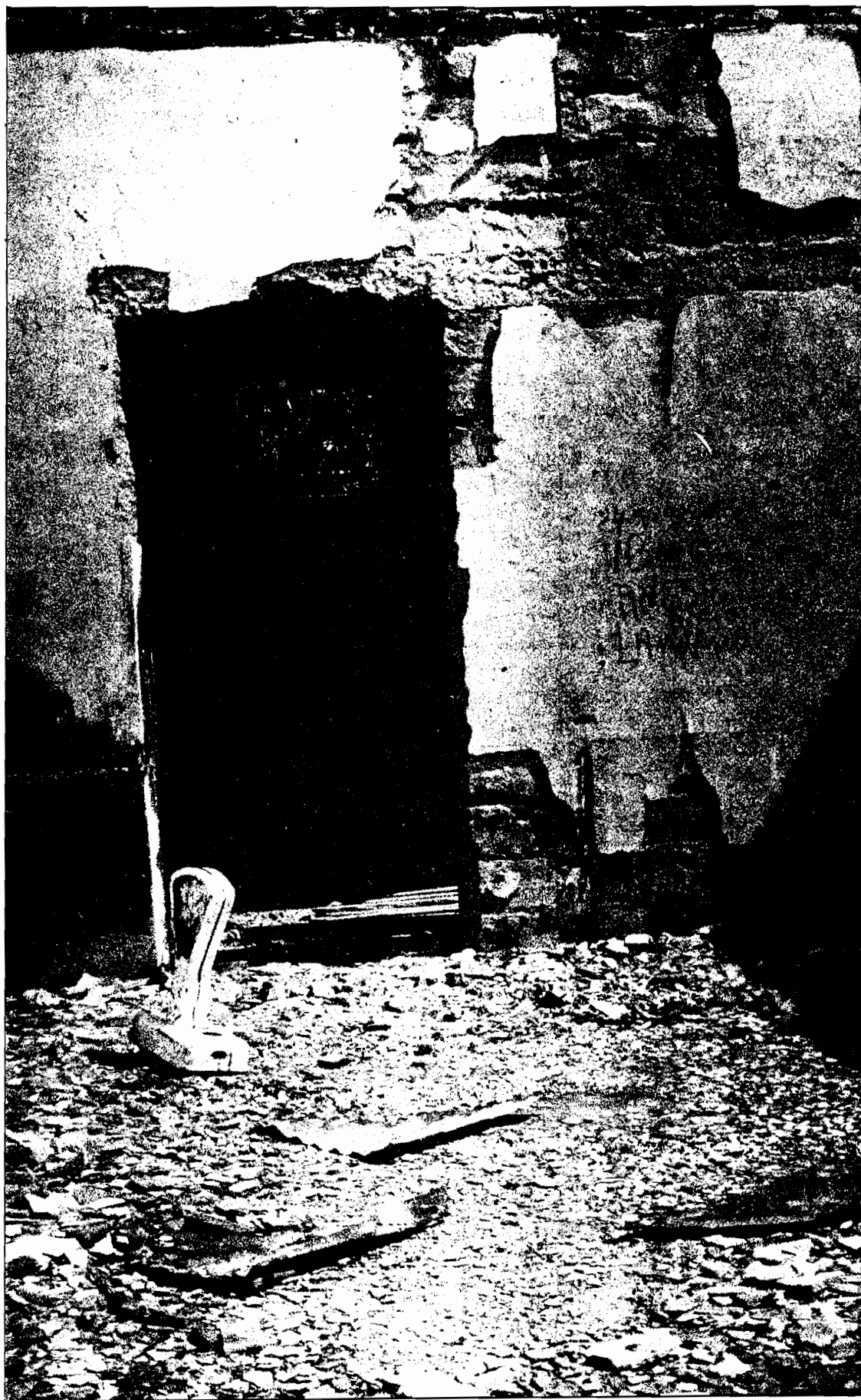
Por onde os bandos passam, as cantinas reduzem-se a isto
