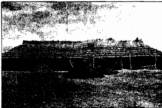
Armazém da cooperativa, construído com material local. O chão foi cimentado com matope
