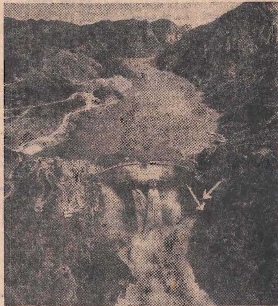
Para se conseguir a libertação económica é preciso executar o plano. Executar o plano significa, entre outras coisas, construir e pôr a funcionar a segunda geradora de Cahora-Bassa, a instalar na margem Norte do Zambeze, conforme o indicam as setas. (Foto de Carlos Alberto)
