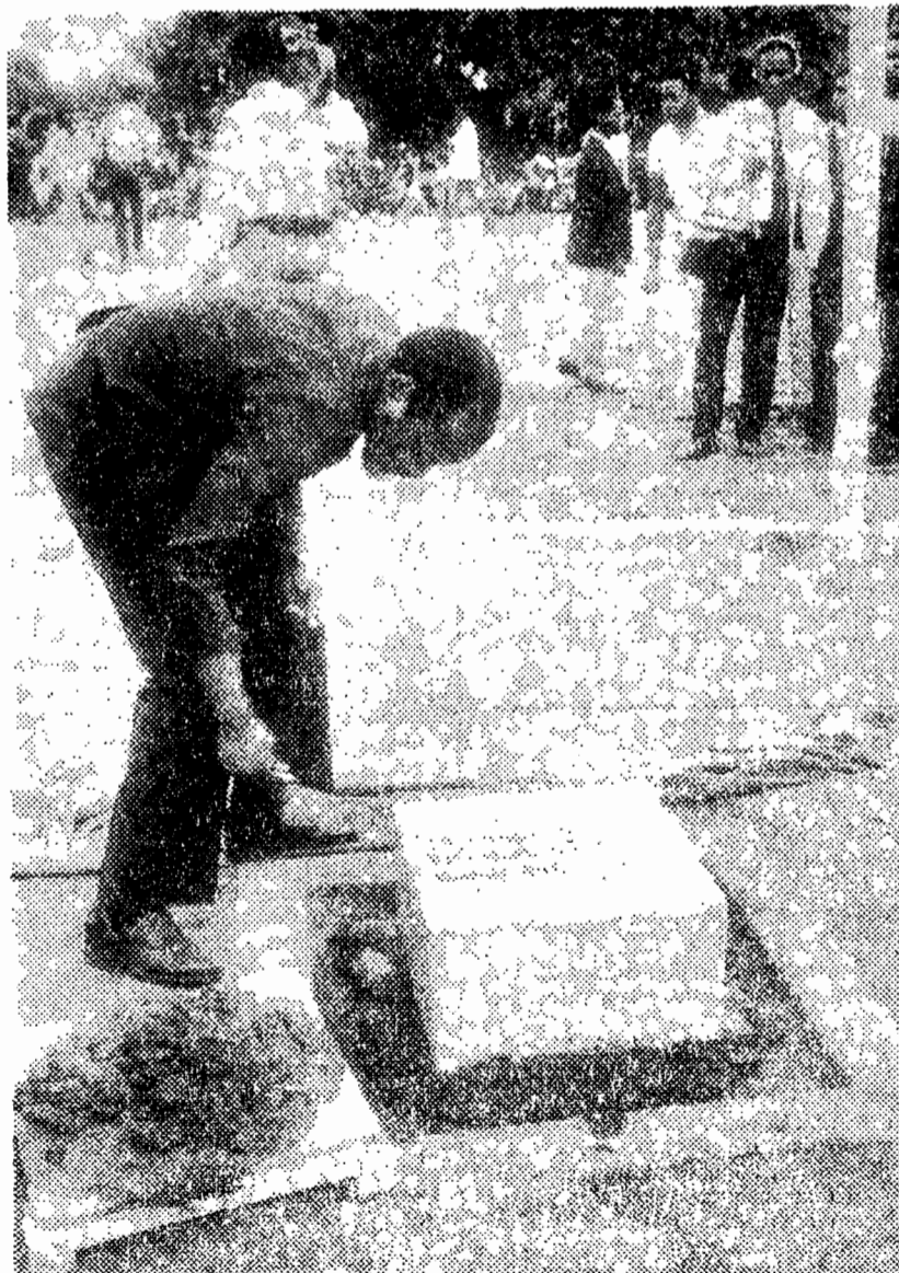
O Presidente Chissano colocou a primeira pedra no local onde será construído o monumento em memória do primeiro Presidente da FRELIMO, Dr. Eduardo Mondlane
