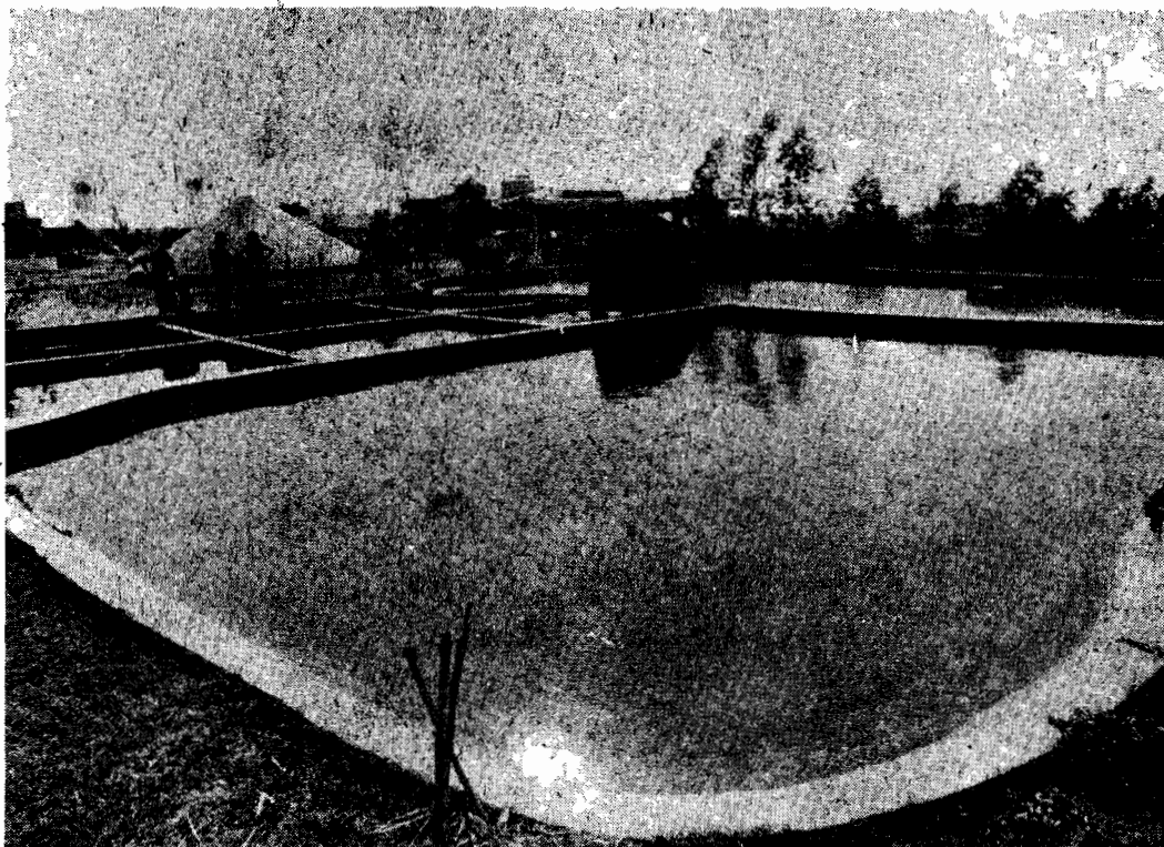
Tanques para piscicultura, igualmente construídos no campo experimental do TBARN, nos locais universitários em Maputo
